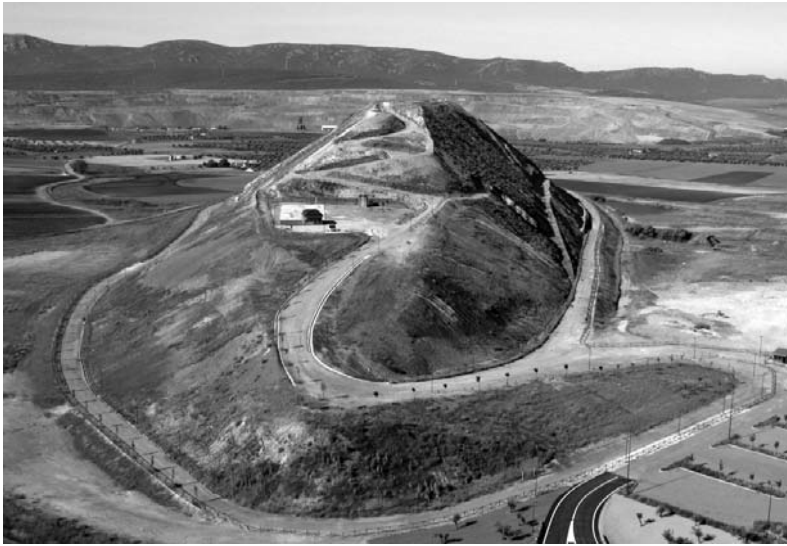
“El Terri” en vista frontal tras concluir las obras de habilitación en Parque. Al fondo se aprecia la corta “Emma” de Encasur. Foto cortesía de ImesApi, sociedad adjudicataria de los trabajos de habilitación.x
